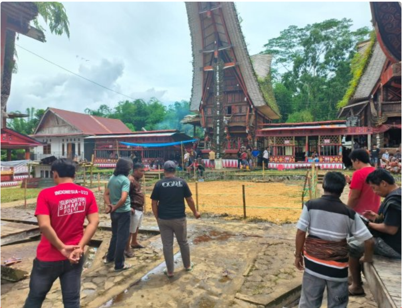
Pembongkaran Arena Judi Sabung Ayam di Sangalla
